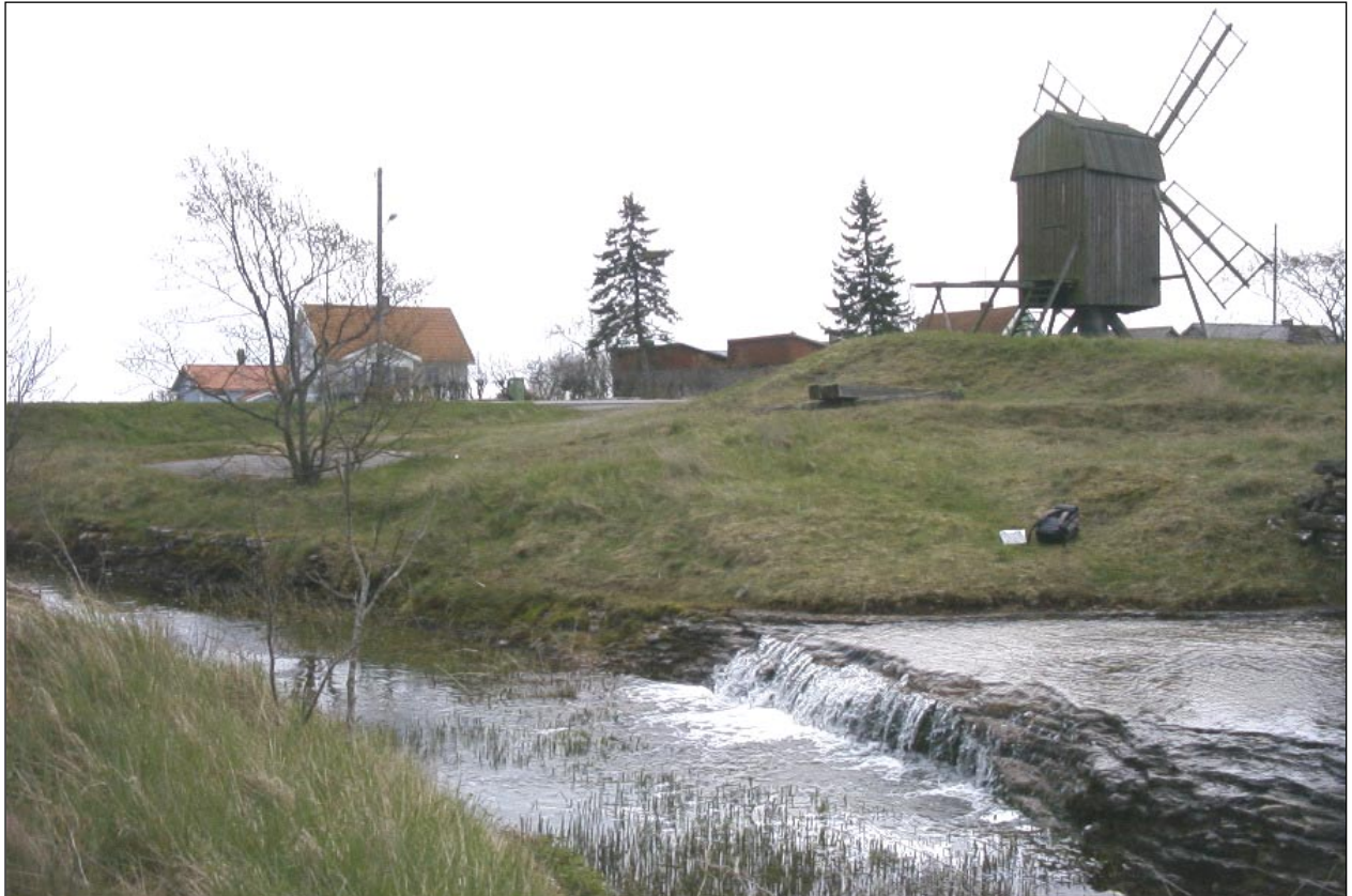
Bild 1. Vandringshindret i Hulterstad väster om landsvägen. Här föreslås ett enkelt omlöp anläggas i vattendraget från fallet och längs med bäckens högra kant ca 30 m nedströms.
