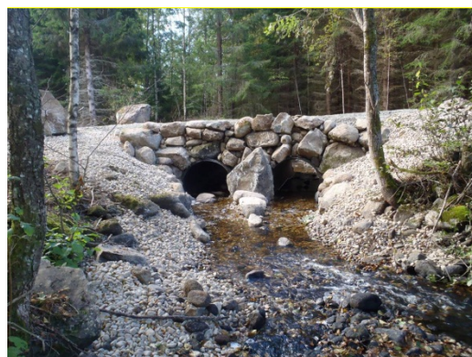
Figur 22. Lagan, Hjørsetån, efter trumbyte vid tidigare vandringshinder
