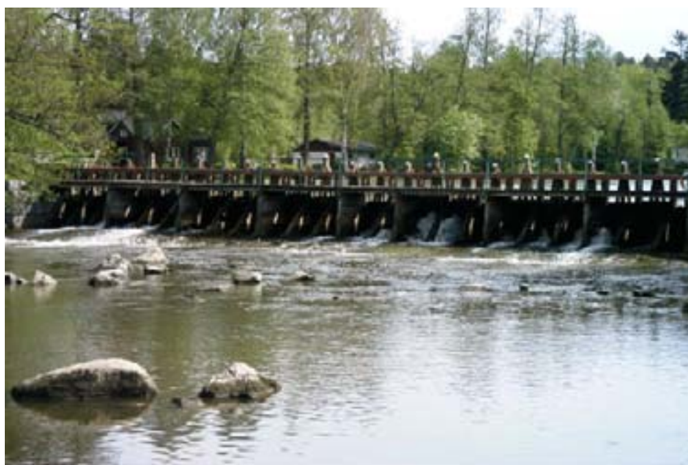
Figur 82. Dagens plats för Simon Lefflers ålkista upptas av Rosenholms dämme som leder över vatten till den nya kanalen ned mot Eskilstuna Stålprensningföretags kraftverk. Detta dämme byggdes 1908. Det är på privat mark och får beundras på avstånd.
