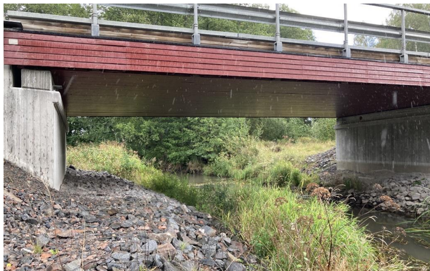
Figur 5. Väg 545 över Kilaälven. Nybyggd bro med strandpassage för däggdjur.
