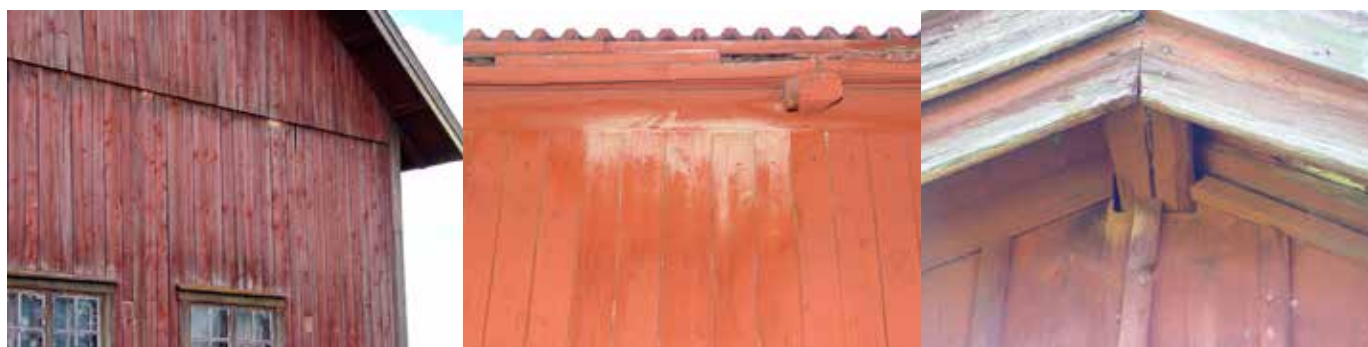
Figur 3. Slitage av barbasteller på väggytor där de slår till för att krypa in bakom gavelspets (vänster) eller väggbrädor (mitten och höger).
