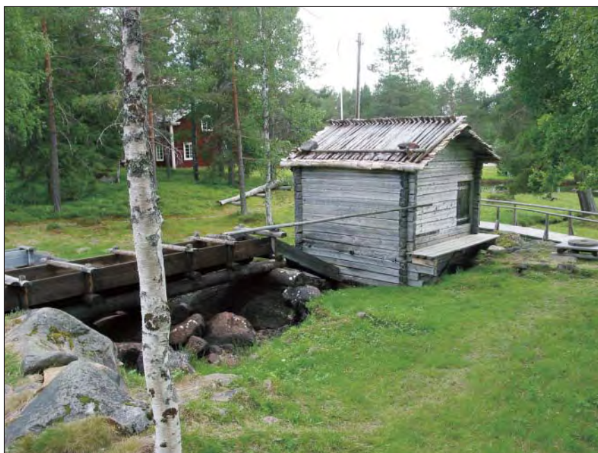
Skvaltkvarn i Torvsjö, Åsele kommun. Sådana kvarnar för malning av säd kunde användas i små vattendrag med liten fallhöjd. Foto: Andreas Grabn.
