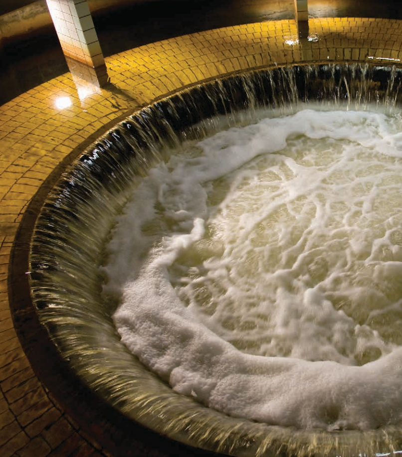
UTLOPPET PÅ HENRIKSDALS RENINGSVERK. BILD: MICKE SANDSTRÖM/STOCKHOLM VATTEN.
